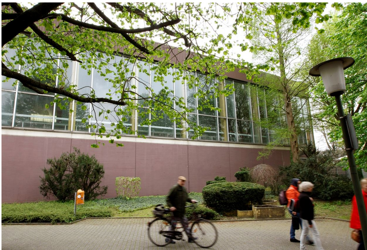
Hallenbad Methler an der Germaniastraße: Ein Defekt an einer altersschwachen Wasserleitung ist aufgetaucht.
