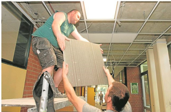
Im naturwissenschaftlichen Trakt der Gesamtschule Kamen erneuern Handwerker die Akustikdecke. Auch die Deckenbeleuchtung wurde ausgetauscht.
