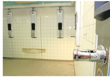
Komfortable Duschen in der Turnhalle des Gymnasiums: Die Brauseköpfe wurden durch Duschpaneele ersetzt.
